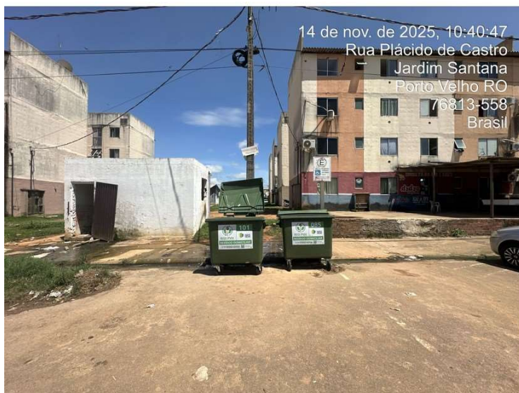
Foto 021: Rua Plácido de Castro - Lixeiras vazias
