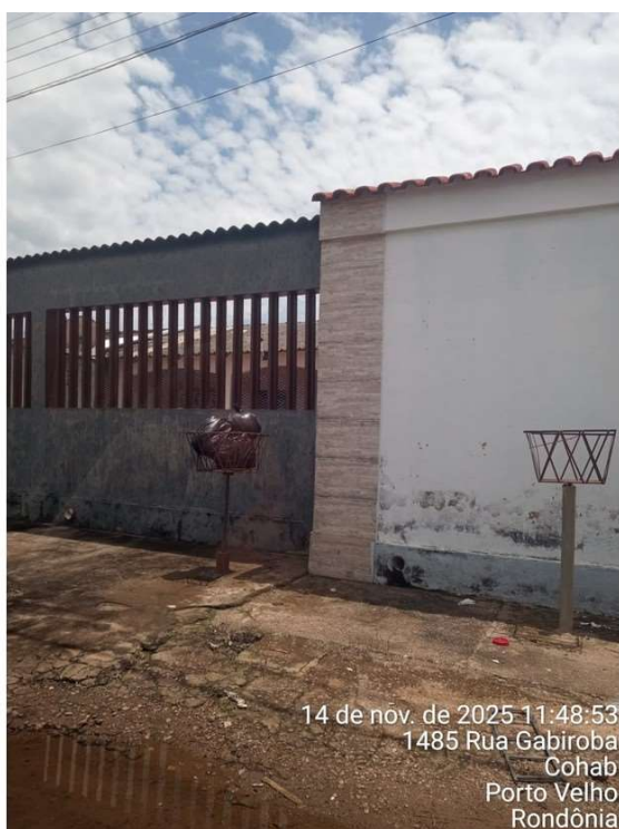
Foto 070: Rua Gabiroba - Ponto com lixo não coletado
